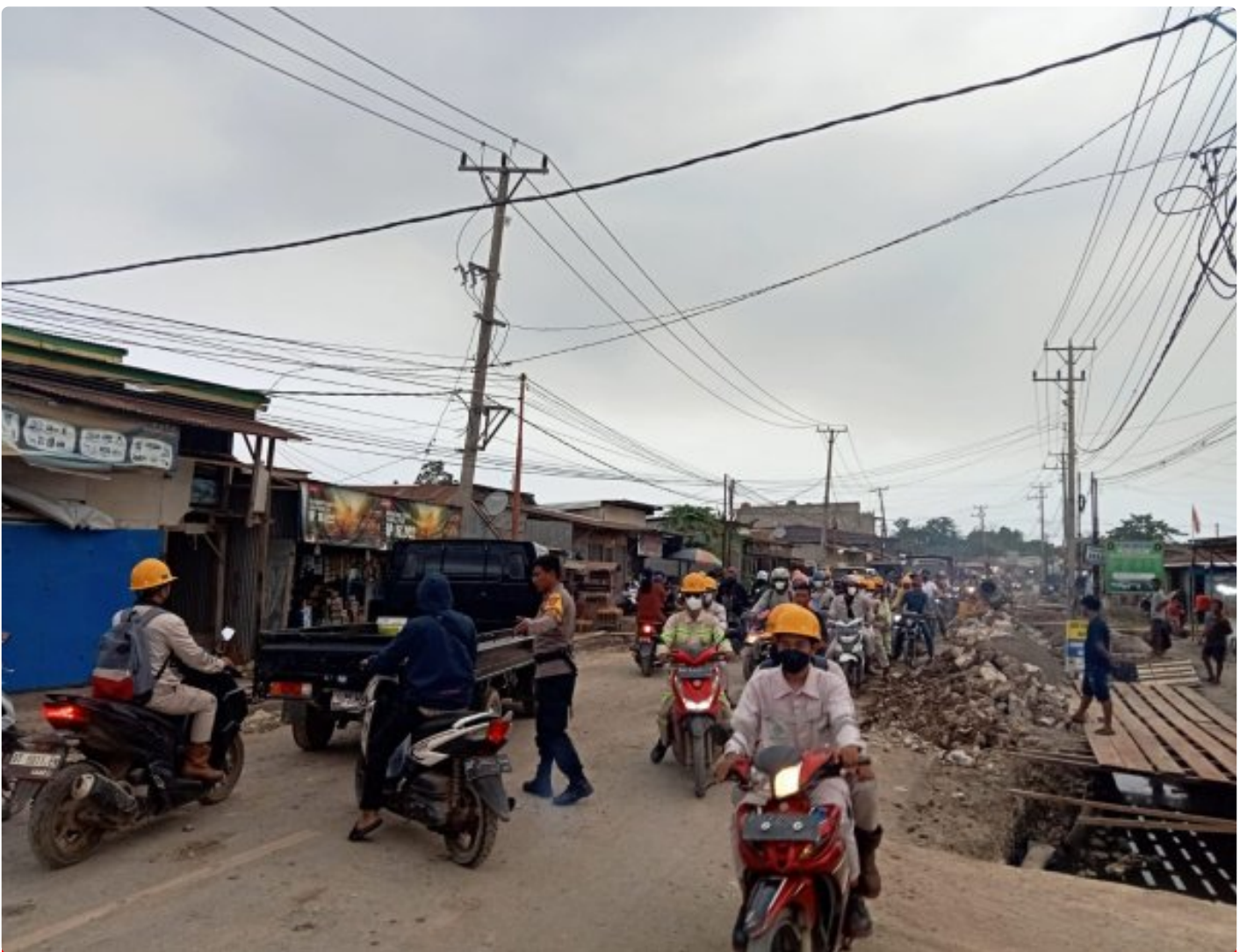
Personel Polsek Bahodopi lakukan pengaturan lalu lintas yang macet akibat pekerjaan drainase, berita Senin (09/12/2024)
